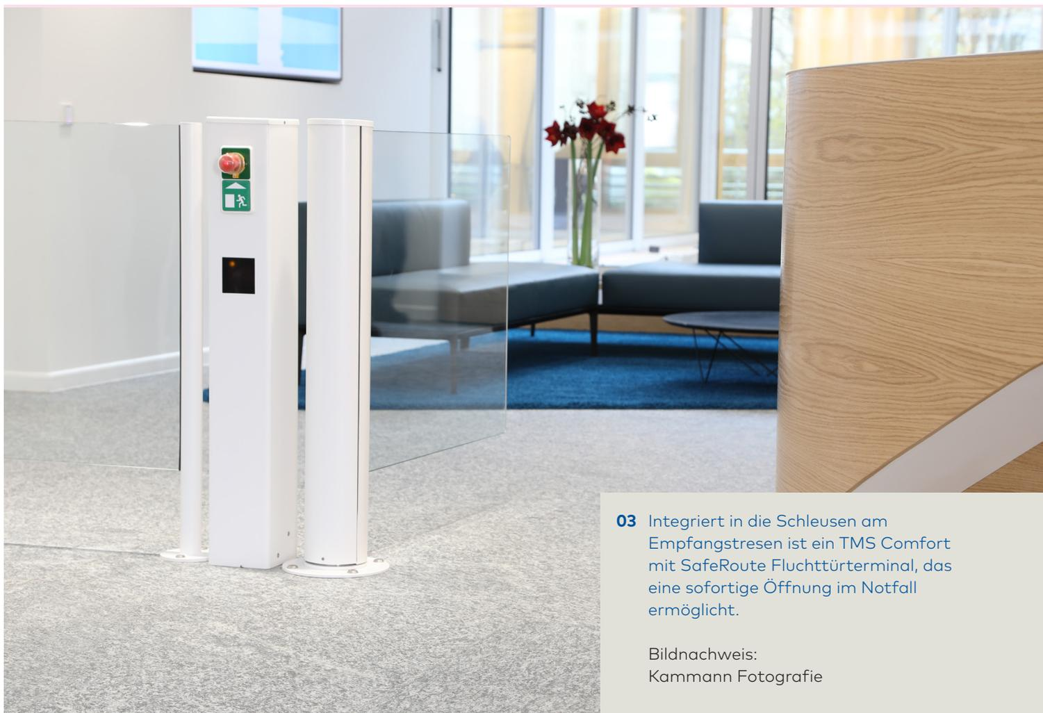
**03** Integriert in die Schleusen am Empfangstresen ist ein TMS Comfort mit SafeRoute Fluchttürterminal, das eine sofortige Öffnung im Notfall ermöglicht.
